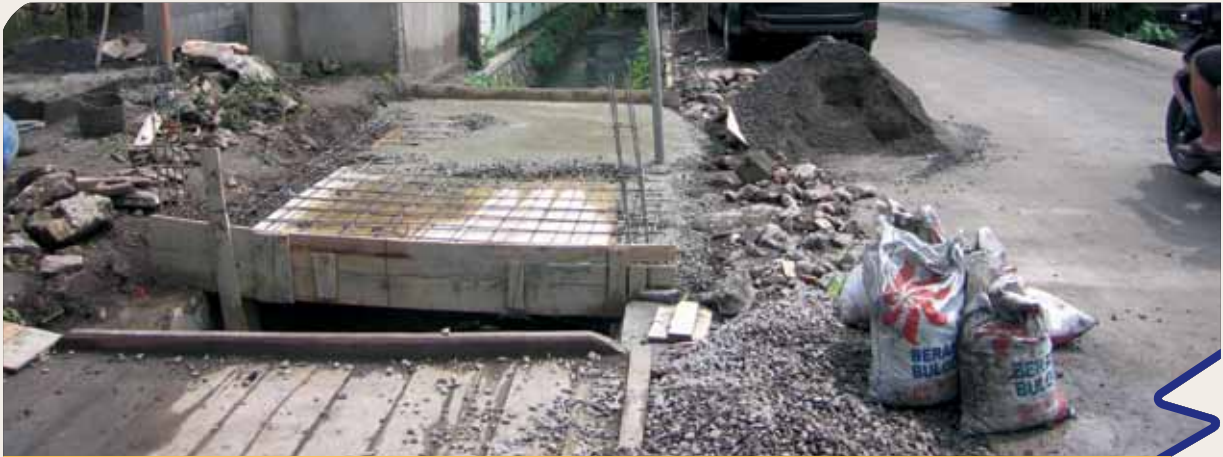
Pembuatan Jembatan SDN Pindad
