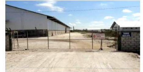
GUDANG BAHAN PELEDAK BANJARMASIN, KALIMANTAN SELATAN
