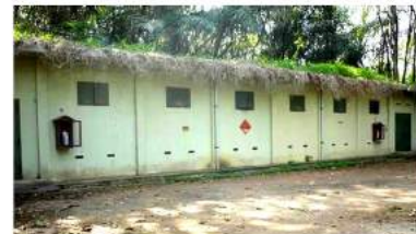
GUDANG BAHAN PELEDAK PRABUMULIH, SUMATERA SELATAN
